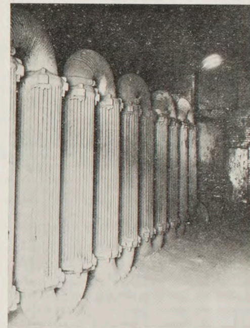
Fig. 8. Eldstadscylinder med värmerör i en ny ugn.
